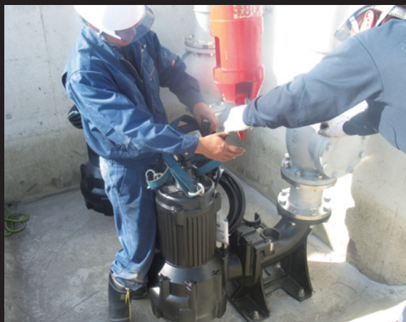
食品工場向け水中ポンプの取替
