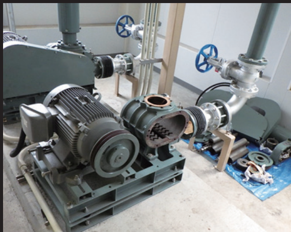
化学工場向けブロワの修繕
