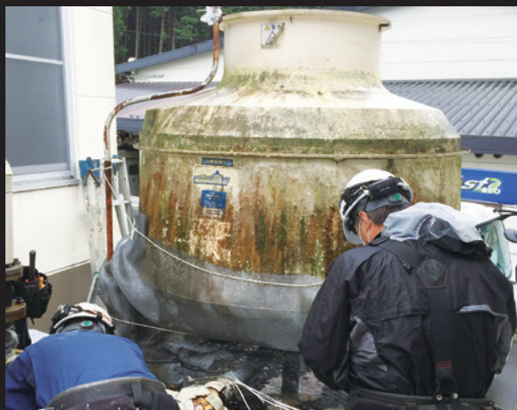
製鉄工場向け冷却塔の取替
