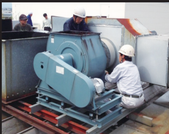
食品工場向け排気用送風機の取替
