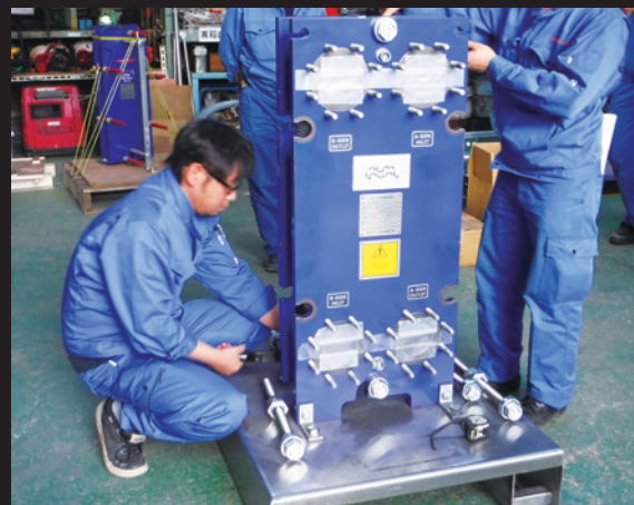
酒造メーカー向け熱交換器の修繕
